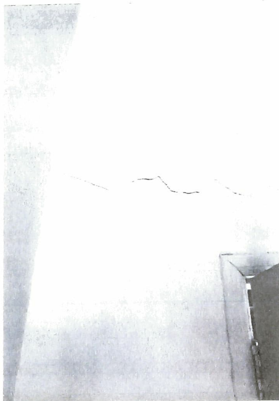
Figura 6 - Trincas sendo causadas pelo sobrepeso da cobertura
