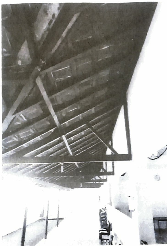
Figura 5 - Telhado "envergando"
